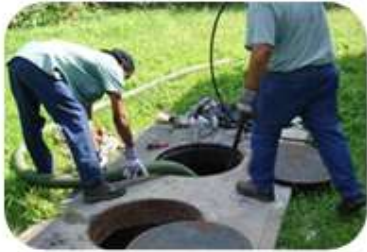
重力油脂拦截器 (GGI) - 室外, 混凝土
