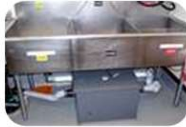
水力机械油脂拦截器 (HGI) - 在地板上或水槽 下面
